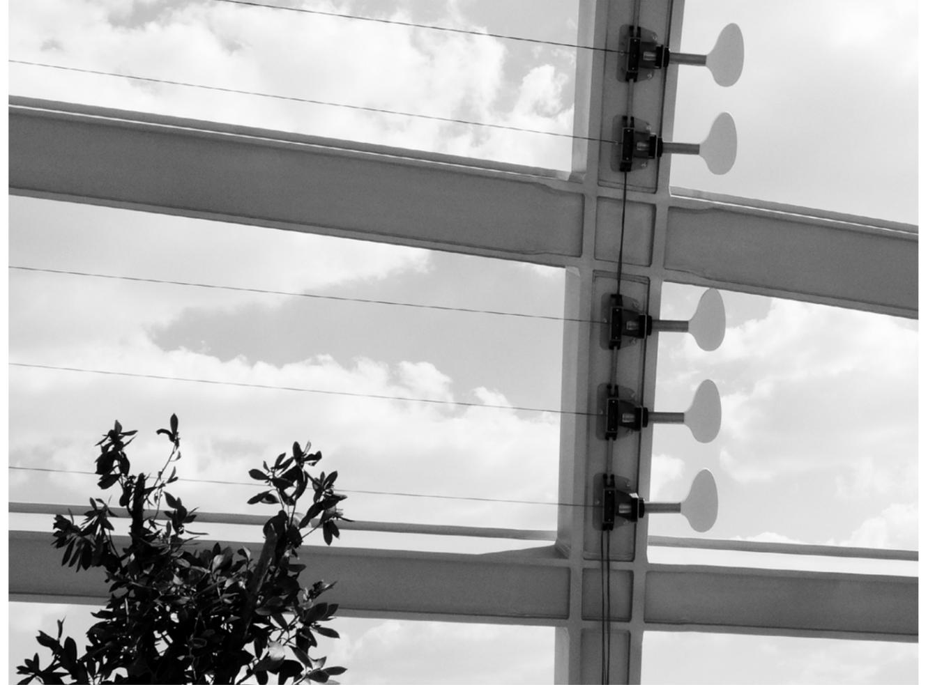
Inspirée d'une harpe éolienne, l'installation *Vent* fait de la passerelle un instrument à cordes, de type guitare électrique, actionné par le vent. Seize cordes sont montées sur les arches et tendues par des clés d'accordage. Leurs vibrations sont captées par des microphones piézoélectriques, transmises au sol à travers la structure métallique, et amplifiées. Les nappes musicales créées par le vent se croisent avec le passage des trains, et enrichissent l'expérience sonore de la passerelle.
